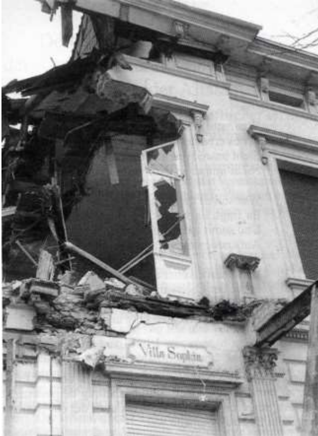
Der Abriss des Sophienstiftes ist im Gange. Foto: A. Kaup.
