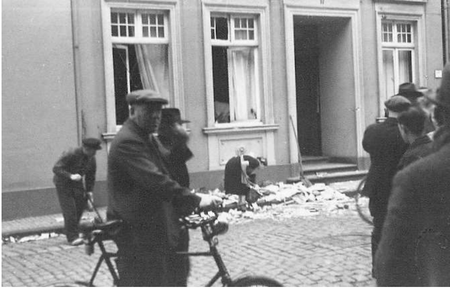
Das Inventar des Hauses von David Elsberg, Oststraße 7, wurde in der Reichspogromnacht 1938 teilweise auf die Straße geworfen; das Foto hier wurde am nächsten Morgen aufgenommen (Foto: Privatbesitz)
